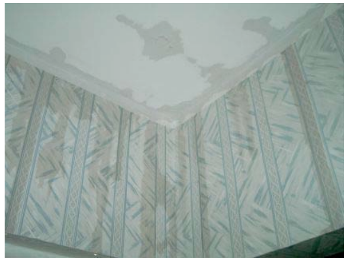
"Schöne" Überraschung an einem Samstag Morgen um 6:45 Uhr: die Nachbarn über uns haben vergessen, das Wasser abzustellen...
